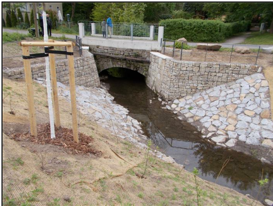
Abb. 5: nach der Maßnahme: Brücke oberstrom Maßnahmebereich, 10.05.2019
