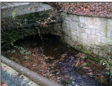
Abb. 1: vor der Maßnahme: Brücke oberstrom Maßnahmenbereich, 15.11.2016
