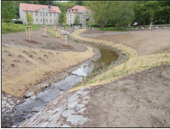
Abb. 7: nach der Maßnahme: Renaturierte Gewässerstrecke, Blick stromauf, 10.05.2019
