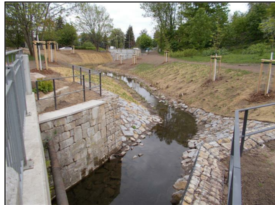
Abb. 6: nach der Maßnahme: Übersicht renaturierte Gewässerstrecke, Blick stromab, 10.05.2019
