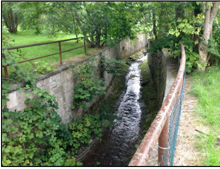
Abb. 2: vor der Maßnahme: Offener Teilabschnitt mit Ufermauern, 10.09.2015
