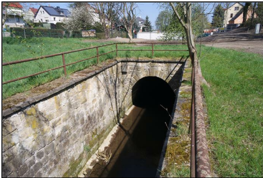
Abb. 3: vor der Maßnahme: Beginn Verrohungsstrecke, Blick stromab, 10.04.2017
